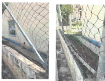
Foto 3: CERCO O MURO PERIMETRAL Sustitución malla de acero galvanizado en perímetro del establecimiento, con instalación fija y tensa, anclajes metálicos en intervalos regulares
