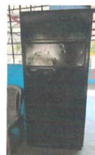
Foto 4: PUERTAS Suministro e instalación de puerta metálica, incluyendo chapa, bisagras.
