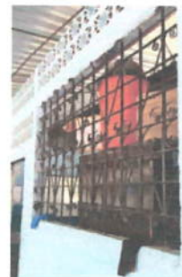
Foto 2: VENTANAS Reparación de balcones metálicos, incluyendo fijaciones, pintura y soldaduras.
