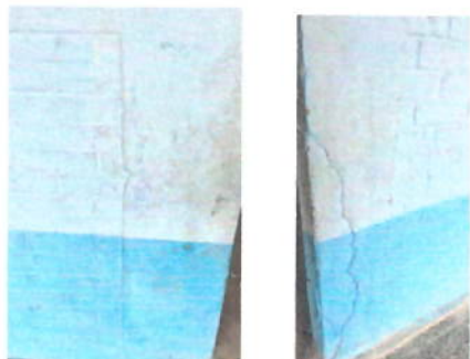
Foto1: PINTURA EN MUROS INTERIOR Y EXTERIOR Preparación de la superficie y aplicación de pintura a dos manos, en paredes interiores y exteriores del establecimiento.
